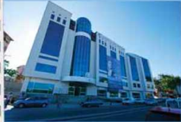
Kartal Belediye Binası
